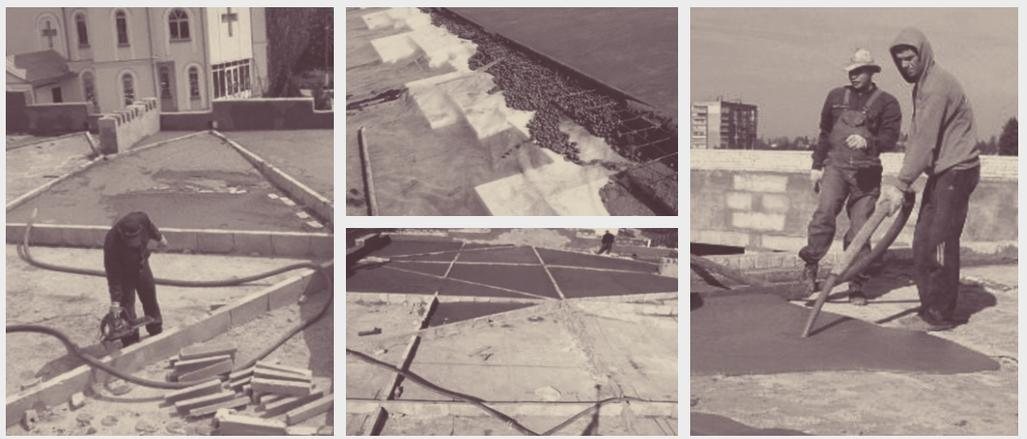
Применение уклонообразующих элементов МК-КЛИН, изготовленных из пенополистирольных плит ППС 20-Р-А по ГОСТ 1588-2014 и СТО-00287823-2021, для формирования уклонов на кровле обеспечивает ряд преимуществ:
